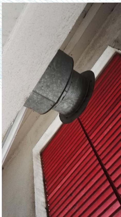
Obrázek 18: MB_2 – komora sání VZT jednotek technické místnosti 3.4
