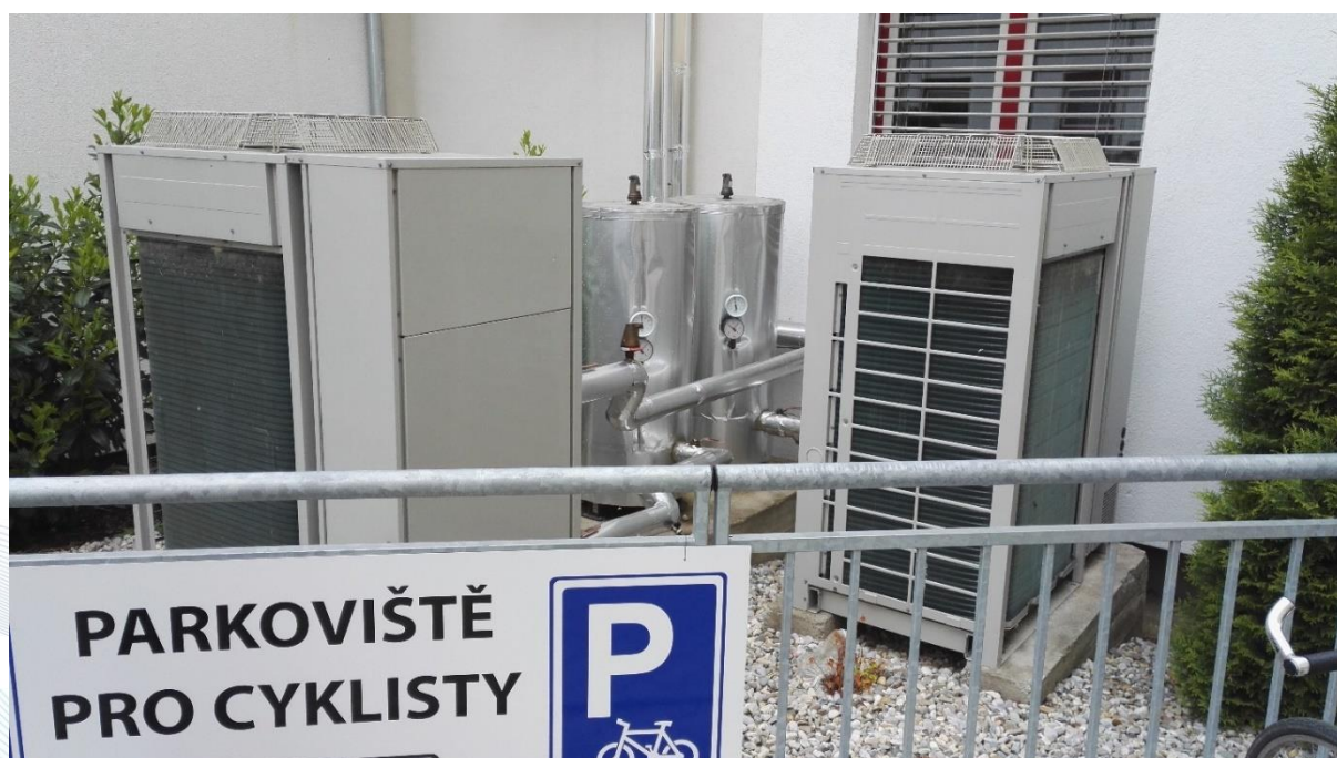
Obrázek 26: MB_10 – 2x klimatizační jednotka u pavilonu CH1
