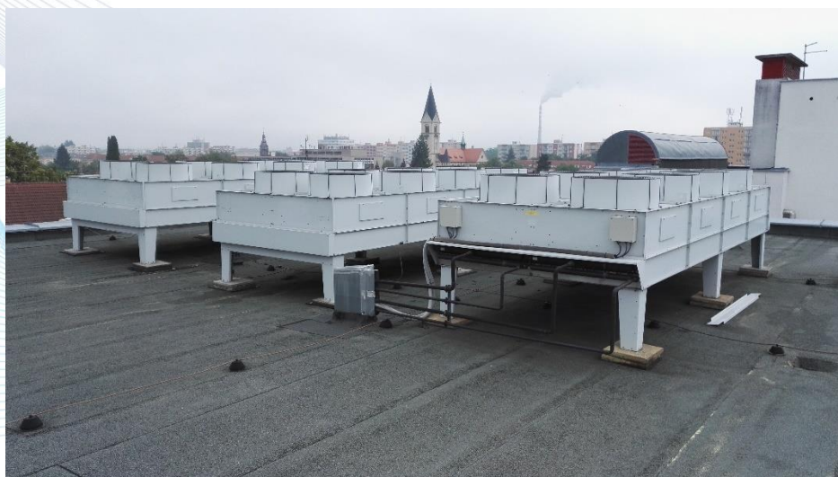
Obrázek 29: MB_12 - 3x chladič jednotka na střeše pavilonu CH
