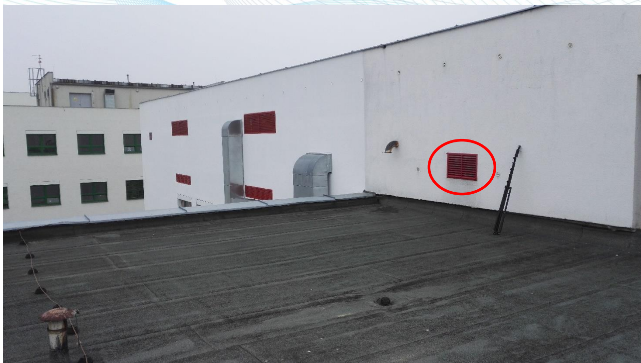
Obrázek 20: MB_4 – výdech VZT jednotky septického operačního sálu z technické místnosti 3.4
